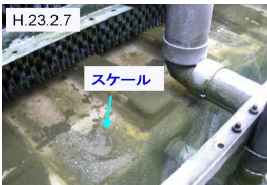
H.23.2.7テスト終了時タワー内にはタワー及び機器等から溶解流出したスケールが凝集沈殿しているのが確認できた。
