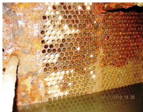
2010年 電磁式水処理装置の設置前 熱交換器の内部
