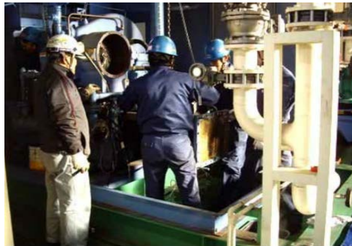
コンプレッサー分解作業中
