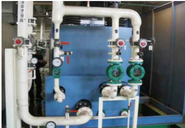
3号機コンプレッサー外観(正面)
