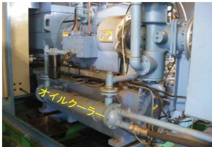
3号機コンプレッサー外観(側面)
