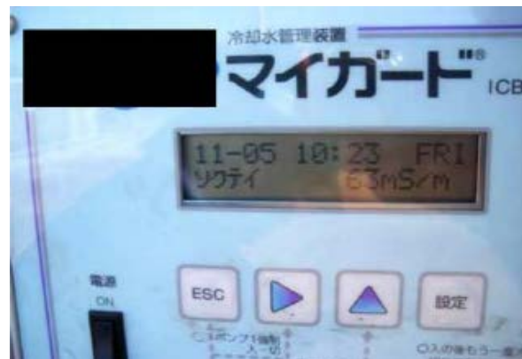
自動ブロー装置設定値は 下限55～上限65ms/mとして 薬品注入時と同等の管理値
