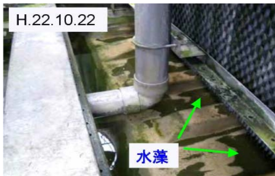
H.22.10.22テスト開始時のタワー内には、水藻の堆積が見られた。
